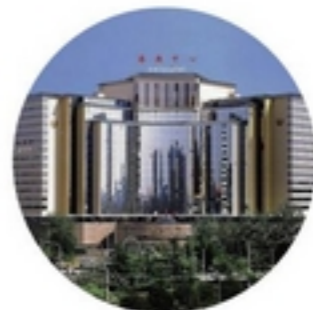
港澳中心项目
