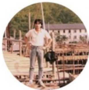
摄于杭州黄龙饭店工地
